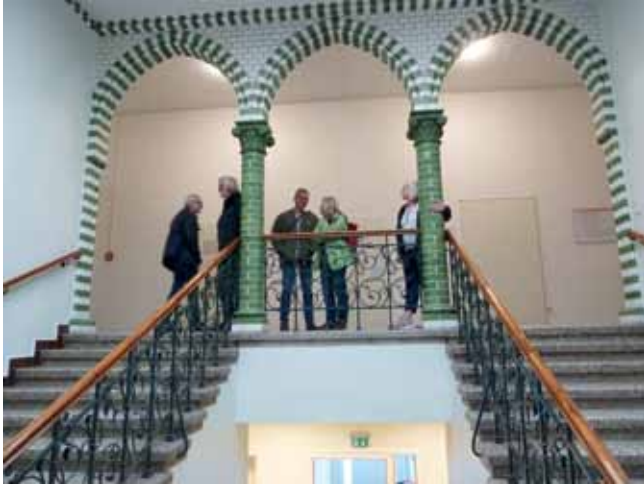
Bögen aus glasierten Ziegeln. Das Treppenhaus, Blick von unten. Foto: Werner Preuß
