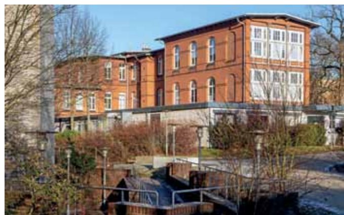
Krankenhaus. Foto: t&w. LZ, 15.12.2022
