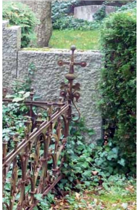
Ein reich verzierter schmiedeeiserner Eckpfeiler („Kreuzblume“) ist als Rekonstruktionsvorlage erhalten. Foto: Preuß
