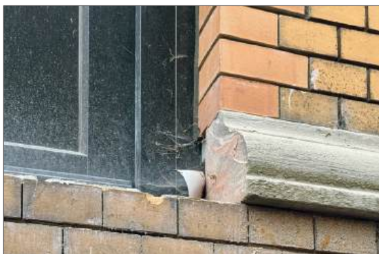
Das Gesims wurde durchgesägt, die Mauersteine unter dem Fenster herausgeschlagen. Foto: Hajo Boldt, Juli 2025
