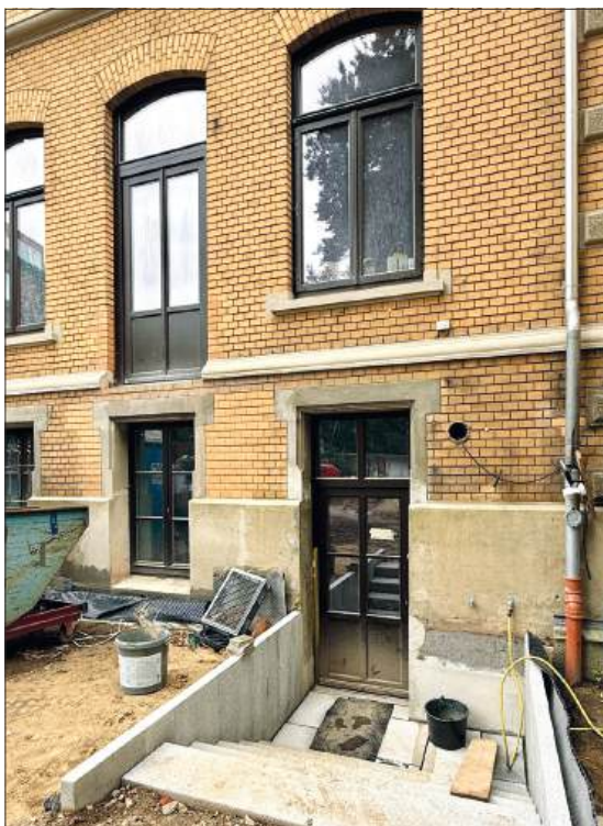
Die ins Mauerwerk gesägte Tür im Hochparterre auf der Nordseite, darunter das zurückgebaute Kellerfenster, rechts daneben der Abgang in den Keller. Foto: Hajo Boldt, Juli 2025
