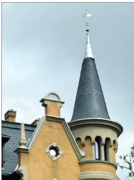
Die Neueindeckung des Turmhelms mit verschieden großen Schieferschindeln mutet seltsam an. Foto: Hajo Boldt, 2025
