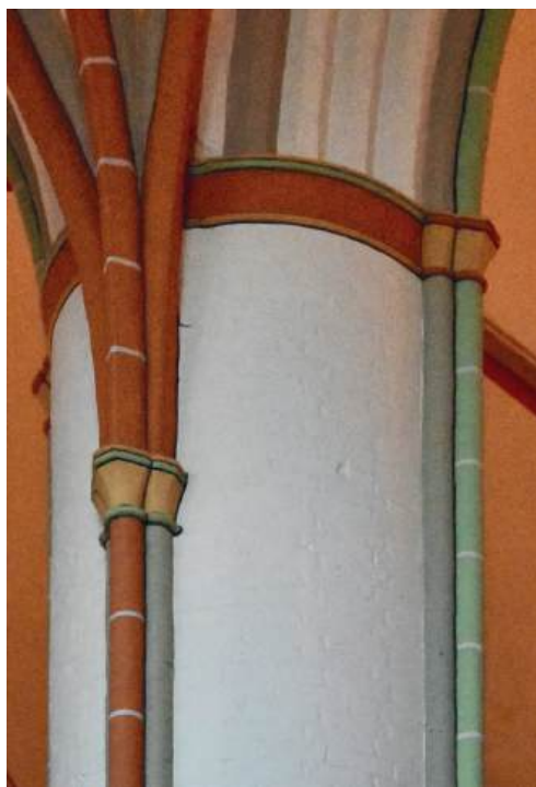
Abb. 8: Säule St. Johannis Lüneburg mit Diensten und Gewölbeansätzen
