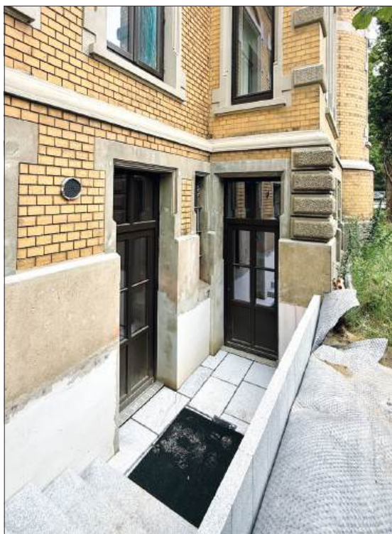
Der Abgang aus rauen Granitplatten ins Souterrain an der Westseite. Die Fenster sind zu Türen verlängert und Lüftungslöcher in die Wand gebohrt worden. Foto: Hajo Boldt, Juli 2025
