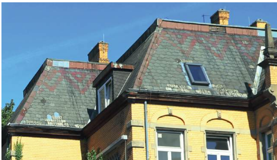
Vor der Neueindeckung des Daches: Rote Schieferbänder überziehen alle Kanten und Dachflächen. Foto: Hajo Boldt, Juli 2018
