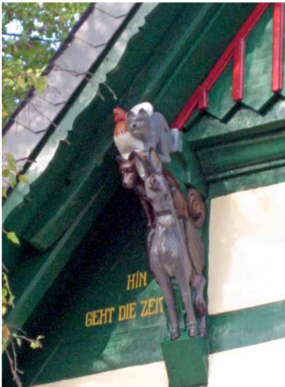
Die Igelschule an der Dahlenburger Landstraße 151 zeigt eine Bauweise, wie sie heute selten geworden ist: Heimatschutzarchitektur. Der ALA übernahm die Kosten für die Restaurierung des stark geschädigten Schaugiebels, ARB die Planung.
