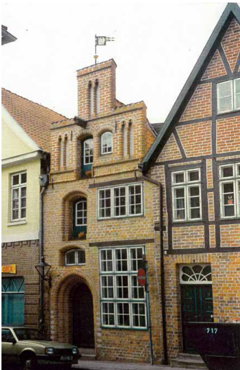
staffeligen Giebelhauses durch Planungsbüro ARB. Die völlig verunstaltete Fassade wurde rückgebaut und am Befund ergänzt. Städtische Bauauszeichnung 1988, Preis der Sparkassenstiftung 1988, Titelbild Bauzeitschrift „Das Haus“ 1991.
