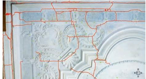
**Abb. 11. Risskartierung (rot) und eingesetzte Schrauben (grün) an der Stuckdecke Nordwestecke (Ansicht von unten).**
