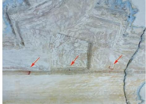
**Abb. 6. Drei Anrisslinien aus Rötels im Randbereich unter der ersten Kalkschicht.**
