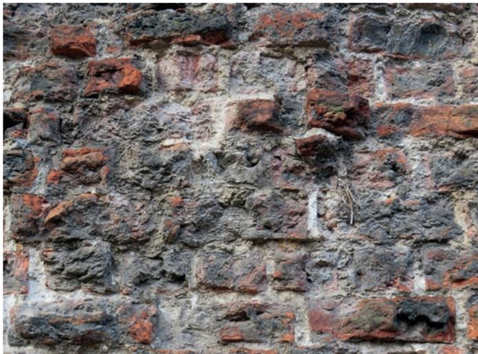
**Abb. 6. Starke Schädigung des Mauerwerks um 1400. Abbröckeln und Schalenbildung der Ziegel durch Salzbelastung. Reduktionskern der Ziegel sichtbar. Foto: C. Abheiden**
