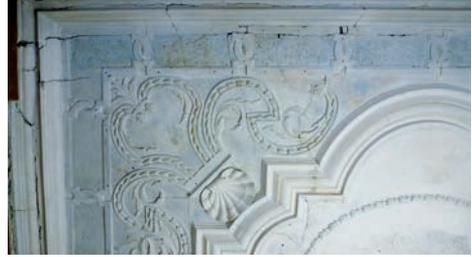
**Abb. 13. Ein Deckenstück nach der kompletten Freilegung der originalen Oberfläche und der Sicherung der gelösten Stuckfragmente.**
