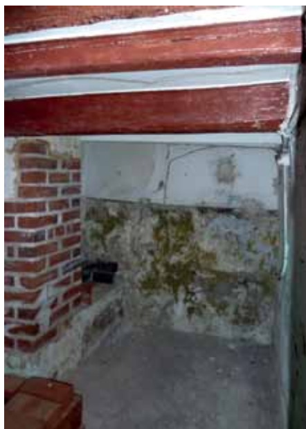
Niedriger Küchenraum hinter der Stube im Erdgeschoss
