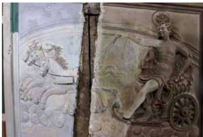
02 Der Bereich des SOL mit starken Beschädigungen und teilweise verfälschender Farbfassung in den verschiedenen Zimmern (ehemals getrennt durch eine Wand).
