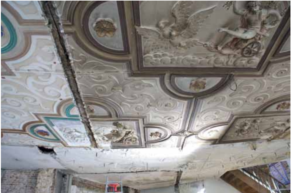
01 Die Renaissance-Stuckdecke mit der Darstellung der sieben Planetengötter (um 1620) vor der Restaurierung, die ehemaligen Wände sind schon entfernt.
