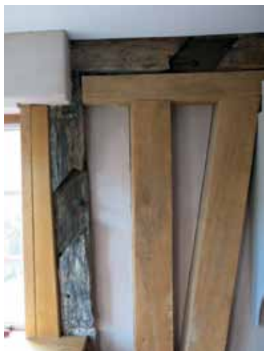
Stütze Deckenbalken im 1. Stock.
