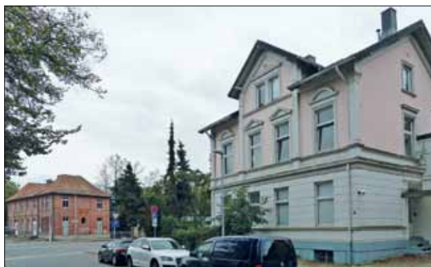
Rechts im Vordergrund das vom Abriss bedrohte ehemalige Wohnhaus Franz Krügers, links im Hintergrund der von ihm 1911 erbaute, später aufgestockte Sothauer Kleinbahnhof (Südbahnhof): Sterbende Zeugen für ein menschliches Maß in der Architektur am Lösegraben ...
