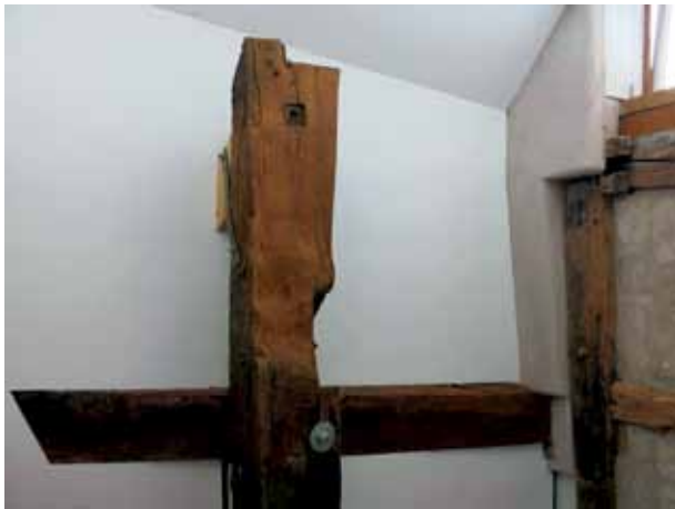
Abgehängter Deckenbalken mit historischer und moderner Aufhängung
