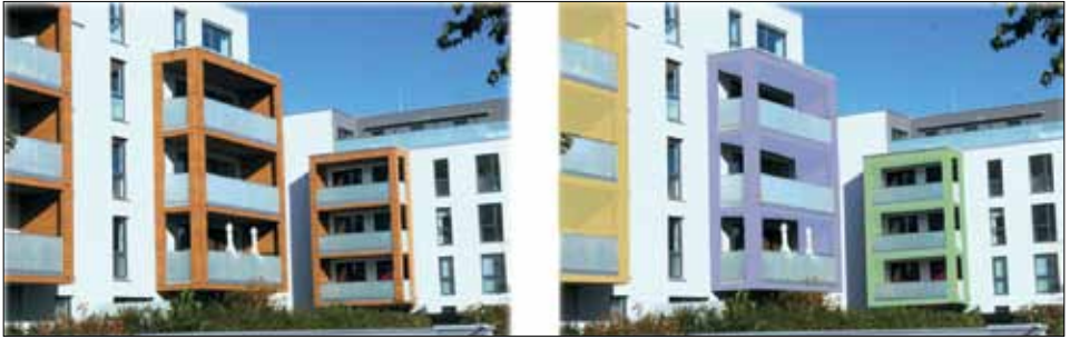
die vorhandene Situation
