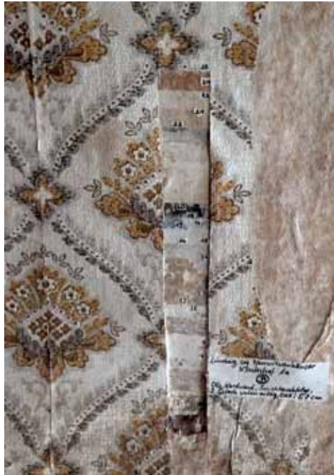
Ein „Fenster in die Vergangenheit“ in der Nordwand des Zwischengeschosses
