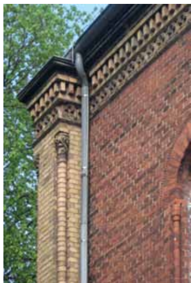
Auf dem Michaeliskloster 8, Detail Gebäude-Ecke und Traufgesims. Foto: Sellen 2015
