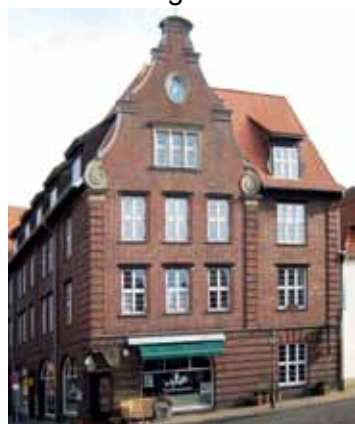
Bei der Abtspferdetränke 1, Gesamtansicht. Foto: Sellen 2017
