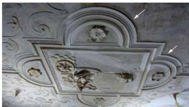
10 Das Feld der VENVS während der Ergänzung des Stuckrahmens und der fehlenden Ornamente in historischer Technik.
