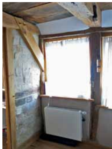
Wiederhergestelltes Kopfbau, Fachwerk innen alt und neu, Deckenverkleidung aus alten Bohlen, Lehmputz und Gipskarton.
