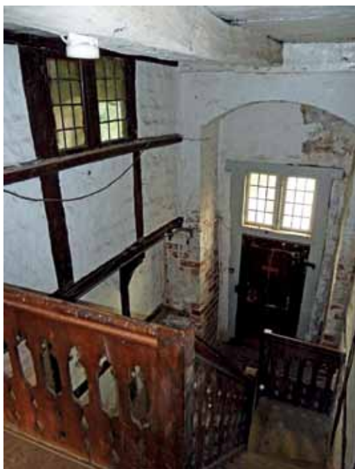
Blick in die Halle des Hauseingangs Nr. 1. Links: das Innenfenster des Zwischengesosses.
