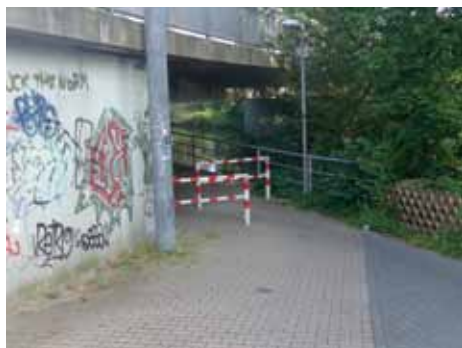
Abb. 4a + b: Umlaufsperrung an der zentralen Achse des Lösegrabens – unnötige Sperre, die mit Anhänger oder Lastenfahrrad unpassierbar ist. Alternativ könnte man mit Schildern und Piktogrammen auf die Gefahrenstelle aufmerksam machen.
