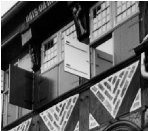
Baumstraße 3, obere Fensterzeile
