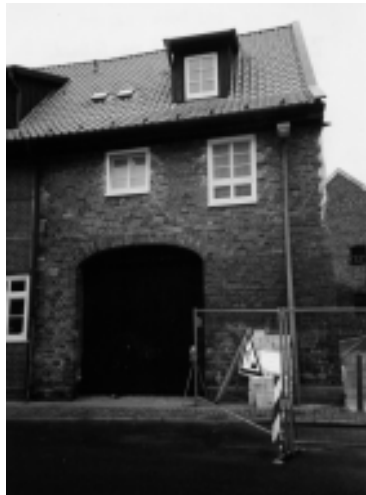
Das Tor gehört heute zum Gebäude links, die Verzahnung, das Mauerwerk und die Torform deuten auf einen ursprünglich zusammenhängenden Komplex hin. So mit alten Häusern umzugehen ist keine Denkmalpflege!
