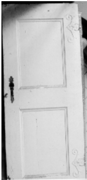
Zweifüllungstür im nicht-restaurierten Zustand, Baumstraße 3
