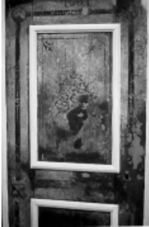
Ansicht der freigelegten Tür von 1601, Auf dem Meere 11
