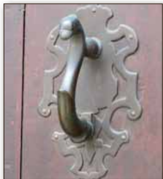
Brömse-Haus Am Berge.
