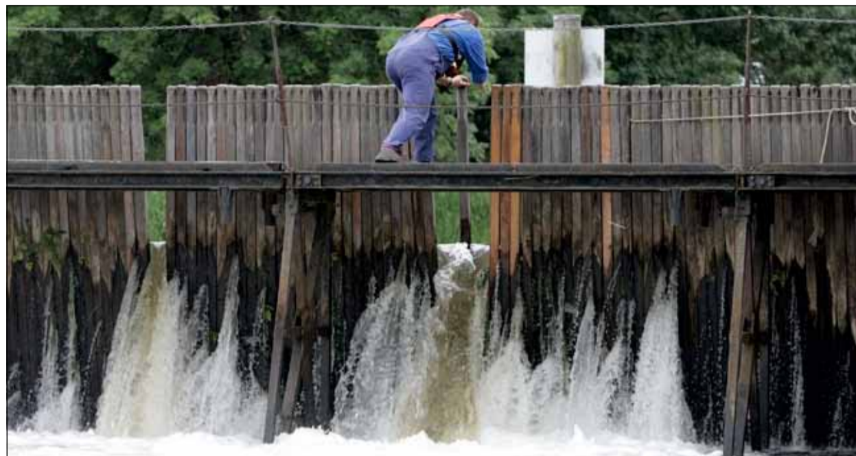
Nadelwehre wie hier in Bardowick sind sehr selten geworden. In Niedersachsen gibt es nur noch vier Stück, und davon stehen drei an der Ilmenau.
