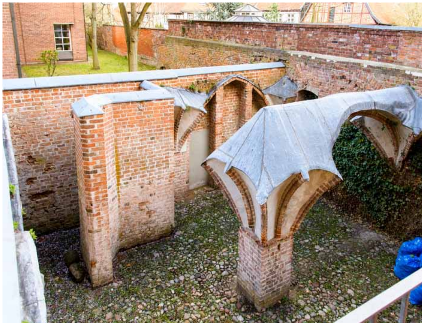
Vom ehemaligen Kapitelsaal an der Michaeliskirche sind nur noch Reste übrig geblieben. Pfeiler und Mauerwerk werden vom ALA gepflegt. Foto: t&w
