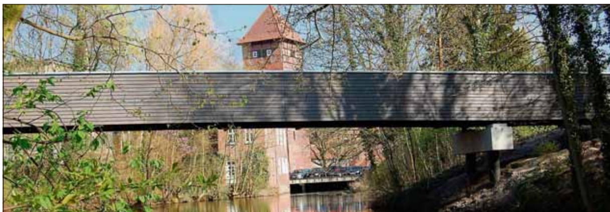
Klobig sei die neue Fußgängerbrücke von der Ex-Nordlandhalle zum Wandrahmpark, findet Leserbrieftschreiber Ralf Gros. Foto: einhorn
