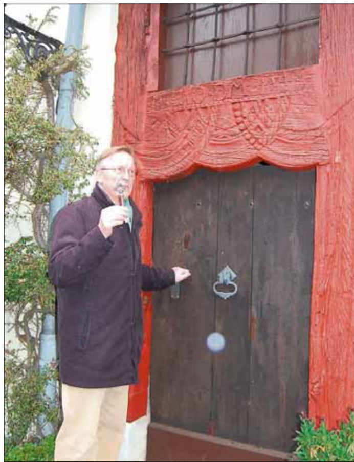
Christian Burgdorff öffnet Hinter der Bardowicker Mauer die Tür zum Tunnel. Der Eingang wurde jetzt restauriert. Foto: ca
