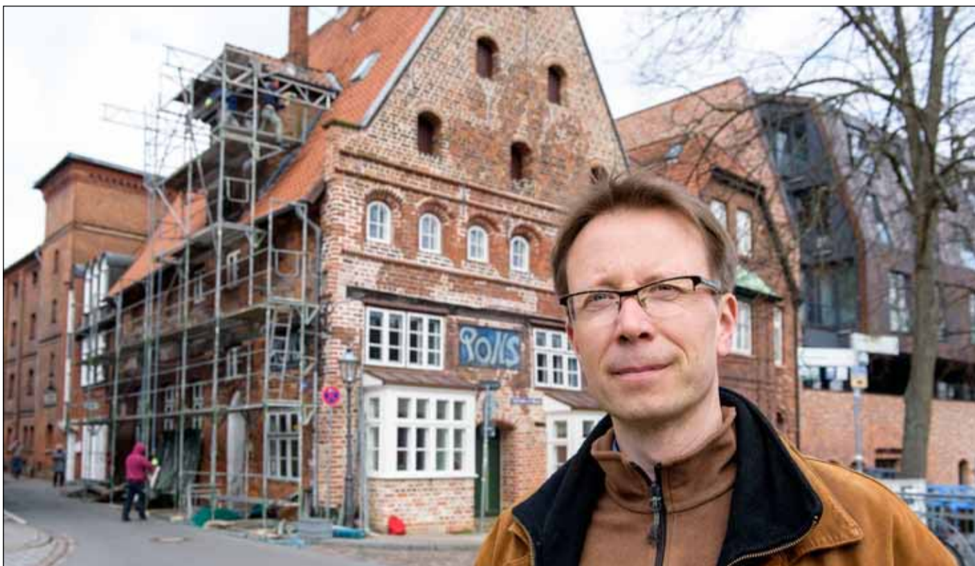
Architekt Gunnar Schulze koordiniert und plant die Arbeiten für die Fassade des Pons-Hauses.
