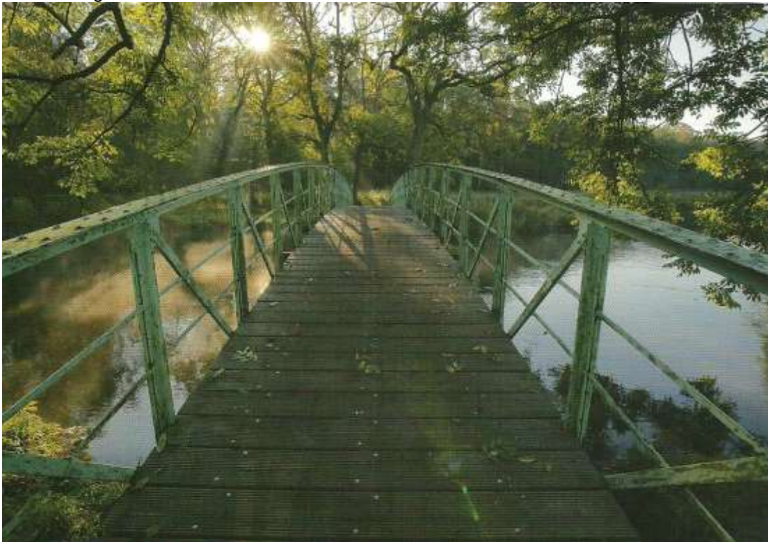
Teufelsbrücke vor der Restaurierung. Postkartensammlung Rüdiger Schulz
