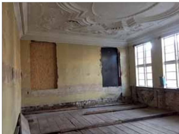
Abb. 7 Einbau der neuen Fensteröffnungen gemäß der bauzeitlichen Situation
