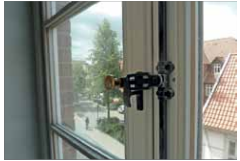
Das Haus Neue Sülze ist denkmalgeschützt. Die Sprossenfenster werden wieder mit den alten Fensterriegeln ausgestattet. Foto: Preuß
