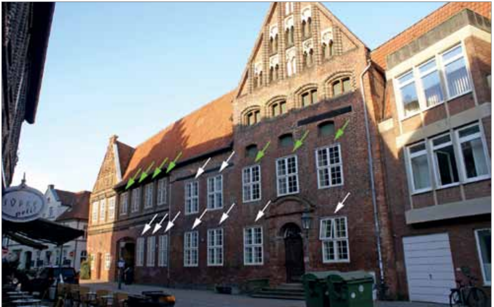
Die Straßenseite An der Münze 7: Die barocken Fenster des Obergeschosses (grüne Pfeile) zeigen sich überwiegend im historischen Zustand. Hingegen sind die Fenster des Erdgeschosses und des Zwischenbaus Nachbauten jüngerer Zeit (weiße Pfeile). Foto: Blohm&Tillwick
