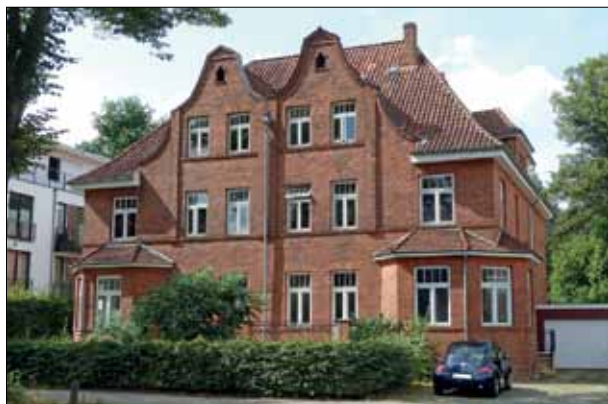
Das restaurierte Haus Uelzener Straße 31/31a, erbaut im Heimatstil mit Anklängen an alte Bremer oder holländische Kaufmannshäuser. Zwei Fensterflügel und Sprossen im Oberlicht besaßen ursprünglich auch die benachbarten Logierhäuser. Foto: Preuß
