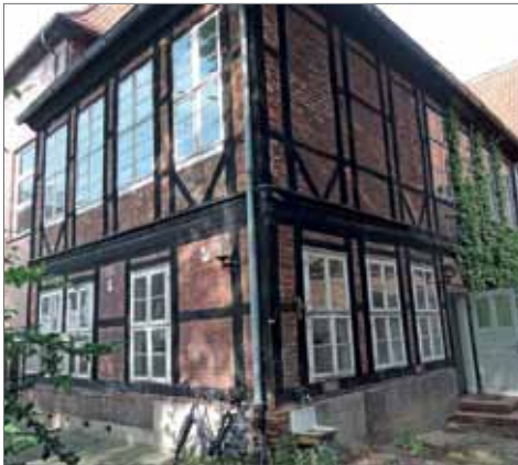
Abb. 1 Der Anbau vor dem Umbau. Alle Fotos, soweit nicht anders angegeben: Wolfgang Gremme / Sandra Hiemer
