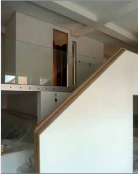
In einen ehemaligen Klassenraum wird eine Galerie eingebaut. Foto: Preuß
