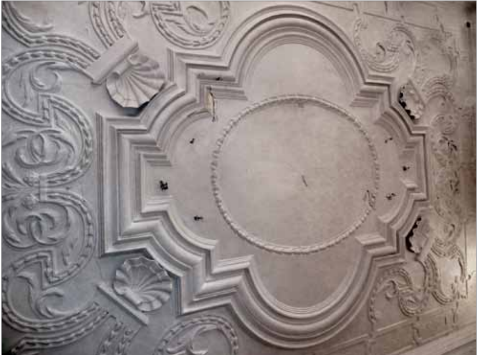
Abb. 2 Die Stuckdecke, Zustand 2019. Foto: Preuß
