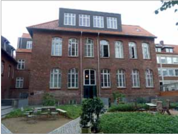
Rückansicht des Gebäudes Neue Sülze 29 und ein Teil des gemeinsam genutzten Innenhofs. Der überdimensionierte Zuschnitt und die Anordnung der Dachgaubenfenster außer der Reihe gehörten schon zum Bestand des Hauses. Foto: Preuß
