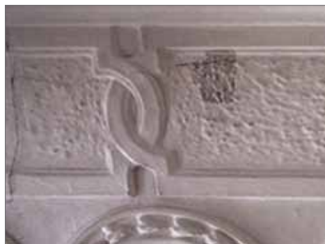
Abb. 6 Glassteinchen im Rahmenfeld. Probefreilegung durch Markus Tillwick, 2018
