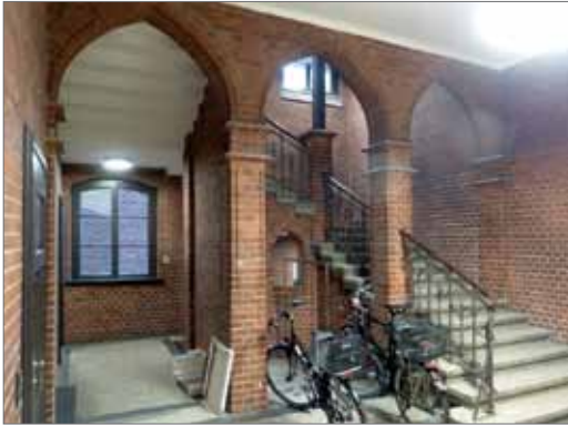
Eingangshalle und Treppenhaus Neue Sülze 29. Foto: Preuß
