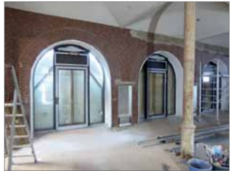
Ausbau der alten Fahrzeughalle
