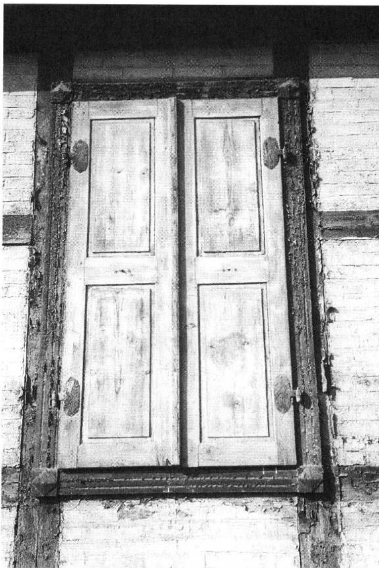
Schlagladen mit Füllungen in Quedlinburg 1.H. 19. Jhdt.
