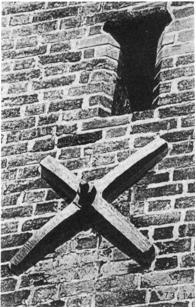
Ankerkreuz aus der Sicherungsphase 1908 - 1909 auf der Südseite des Turmes. Innen liegen die eisernen Ankerstangen direkt vor der Wand des Turmschafftes.
