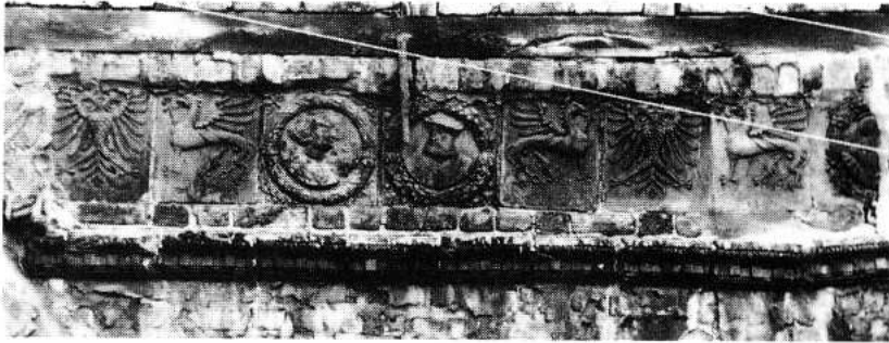
Abb. 3. Lüneburg, Neue Sülze 8, Terrakottafries am Nordgiebel, Aufnahme kurz vor dem Abriß 1961, Photo: Museum für das Fürstentum Lüneburg
