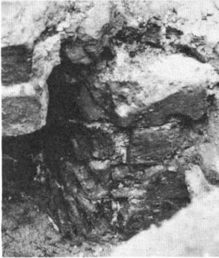
PORTALRESTE UNTER STRASSENIVEAU
